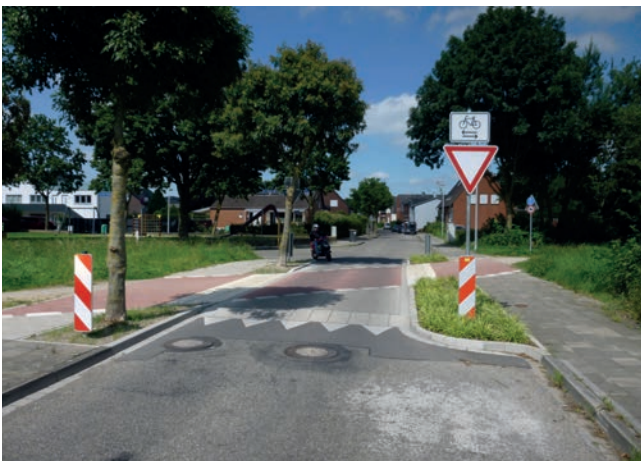
Bild 8-6: Bevorrechtigte Querung einer Straße in Kleve (links) und Skizze zur Bevorrechtigung einer Fahrradstraße mit Anhebung des Einmündungsbereichs der Nebenstraße in Bremerhaven (rechts)
