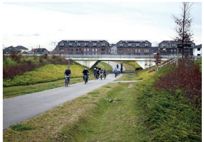
Bild 8-5: Beispiel einer komfortablen Unterführung mit guten Sichtbeziehungen für eine Veloroute in Kerpen
