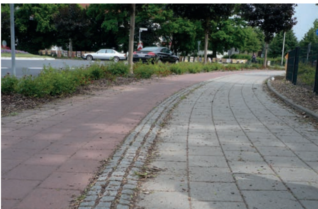
Bild 8-1: Beispiel eines Begrenzungstreifens zwischen Geh- und Radweg aus Kleinpflaster in Düren (links) und Beispiel für einen Trennstreifenstein (rechts)
